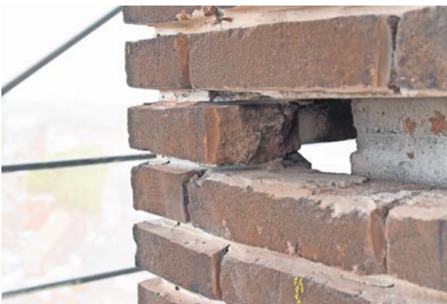
Austausch: 5000 marode Steine werden herausgebrochen und durch neue ersetzt.
