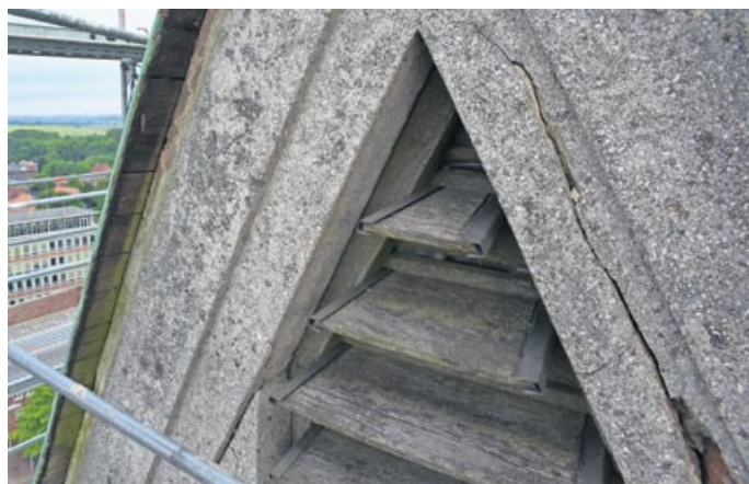
Kraftakt: Am Glockenturm müssen große Betonteile ausgetauscht werden.
