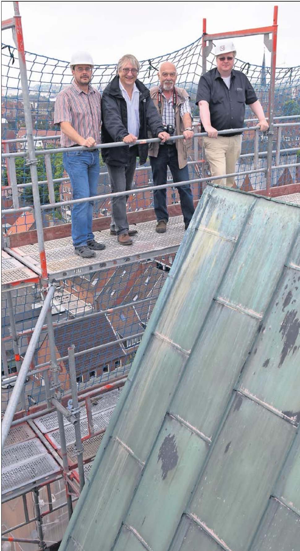
Hoch hinaus: Bauleiter Christian Staudt, Pastor Christoph Jebens, Bauausschussmitglied Hans-Georg Hunger und der Vorsitzende des Bauausschusses, Volkmar Janssen, am Dachfirst des Kirchturms.
